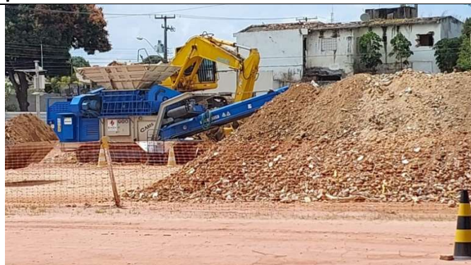
Foto 8 – Detalhe da britagem e pilha de material produzido
